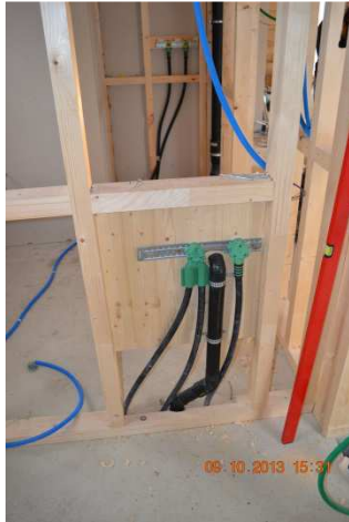
Rohinstallationen (Anschluss Waschtisch)
