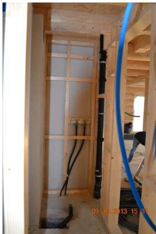
Rohinstallationen (Anschluss Dusche)
